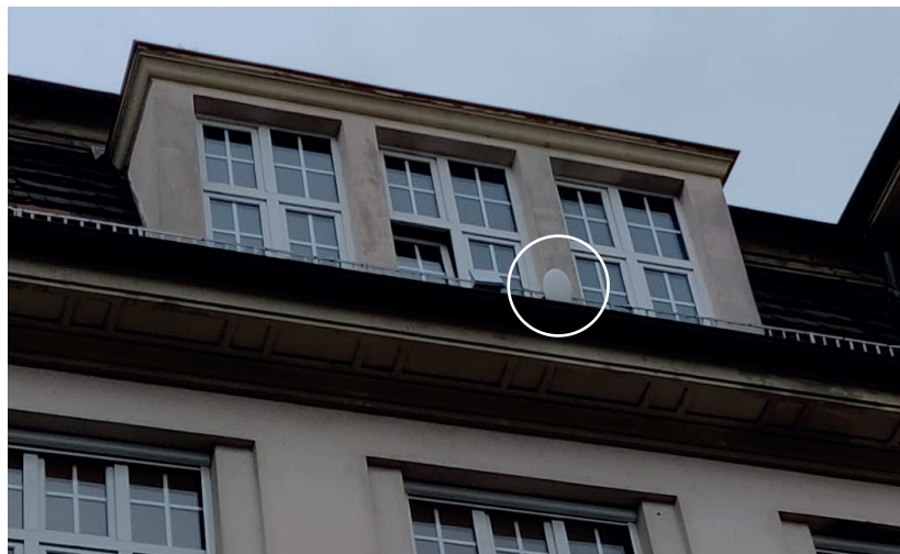
POSE DU CAPTEUR SUR LE TOIT D'UNE ÉCOLE MATERNELLE
